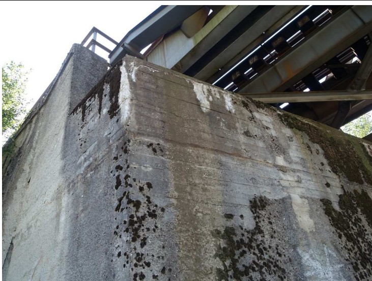
Foto č. 2 Opěra O 02 A – vlevo – průsak vody a pojiva
